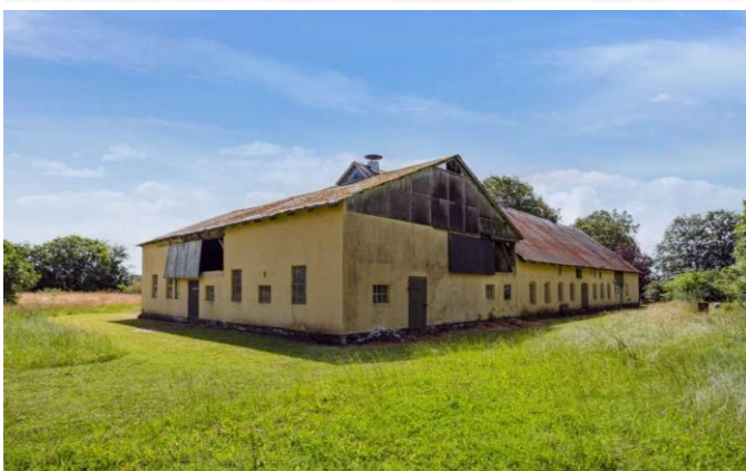
Jernhytvej 50 - opr. driftsbygninger
