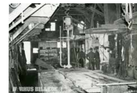
Foto 1959 Aarhus Galvaniseringsanstalt havde til huse i Raaes Gård fra 1920-60. Her ses bygning 7 indefra med den forandrede tagkonstruktion, der skulle gøre plads til en traverskran. 7)
