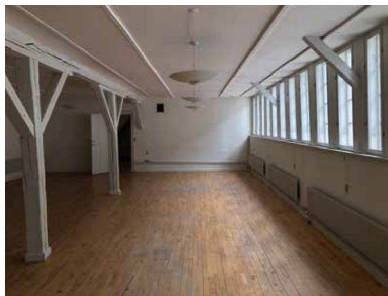
Bygning 6, det åbne rum (tidligere tegnesal) på 1. etage med frilagte konstruktioner og vinduer etableret i det gamle bindingsværk.
