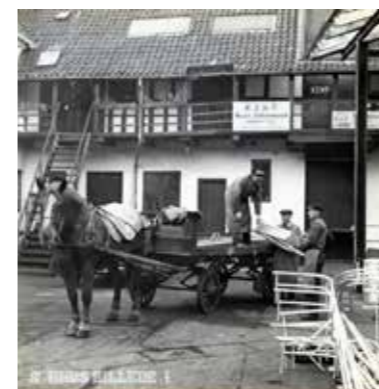
Foto 1951 Nørreport 20 (bygning 6) set fra gårdsiden. Bygningen var i denne periode indrettet som værkstedslokaler for K.E.M.P. Elevator- & Motorservice. 6)
