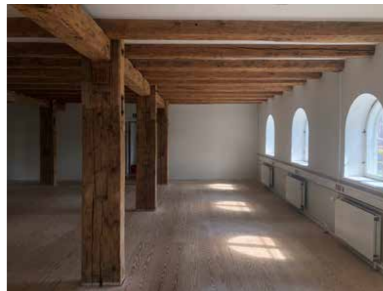
Bygning 1, 1. sal med de frilagte søjle- og bjælkekonstruktioner
